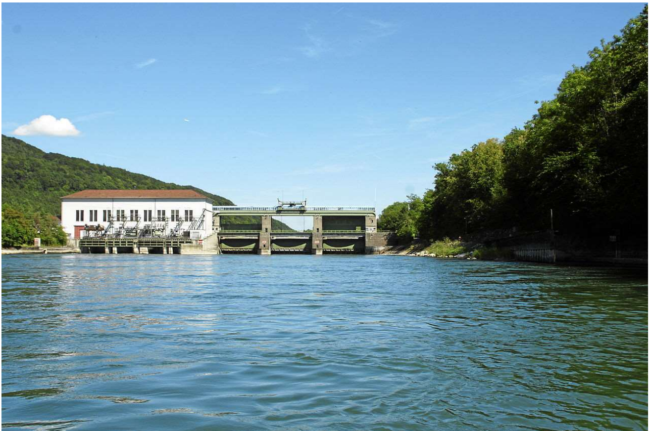
Bild: Blick vom Unterwasser zum Kraftwerk
