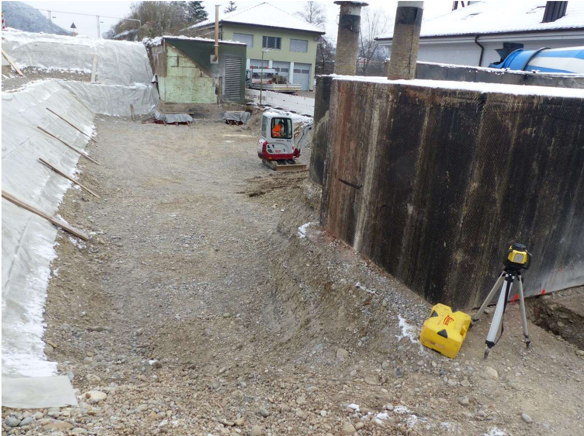
Bild: Baugrube Schaltanlage Spannungsumstellung
